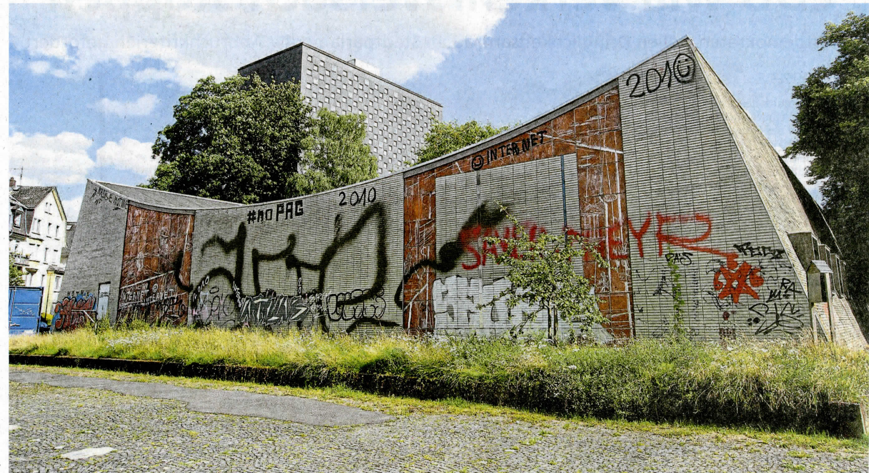
Die Alte UB ist sichtbar in die Jahre gekommen. Das Land als Eigentümer will das Gebäude nun loswerden.
