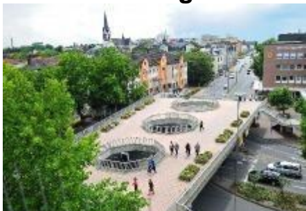
Das „E-Klo“: Das wohl umstrittenste und womöglich auch bekannteste Bauobjekt in Gießen. Foto: Möller
