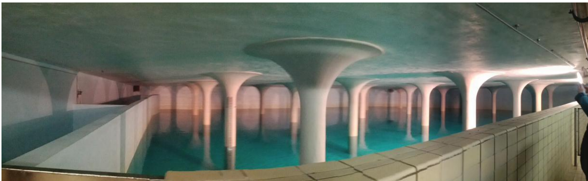
Die Fassung der Buchbrunnenquelle im Egau-Wasserwerk unterhalb Dischingen
